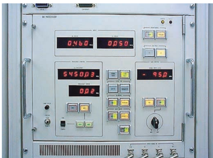
観測レーダー受信処理ユニット
